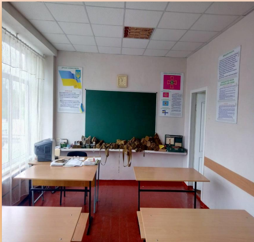
Капітальний ремонт кабінету “Захист Вітчизни” – 12 810 грн.
